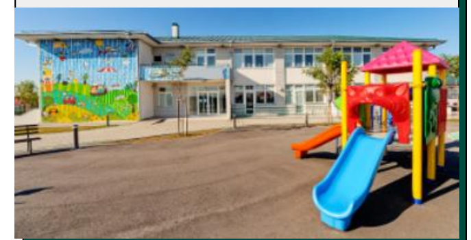
IMPIANTI DI RISCALDAMENTO PER LE SCUOLE
