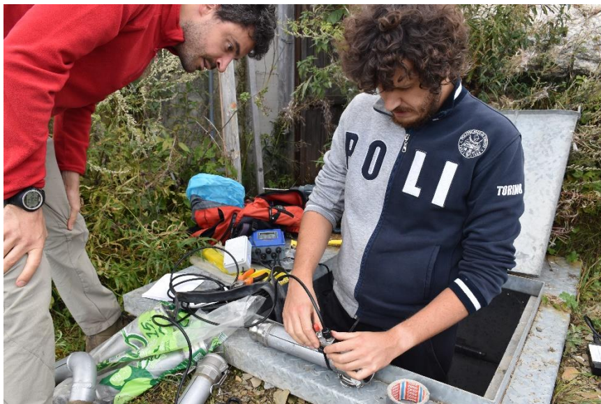
Test misuratori di portata a ultrasuoni clamp-on
