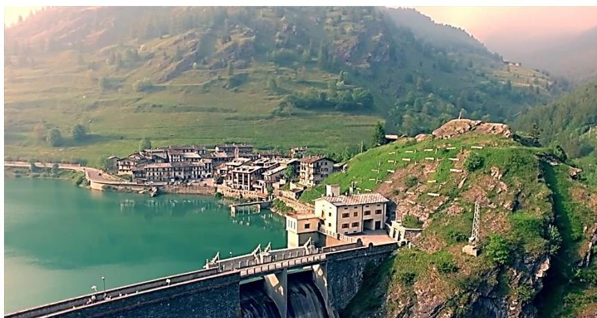
Figura. 2.6 Diga Castello con il lago artificiale di Pontechianale, esempio di derivazione a serbatoio.
