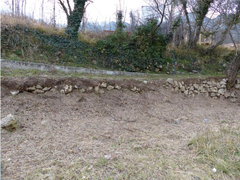
*Muro di contenimento degradato, in alcuni punti mancante*
